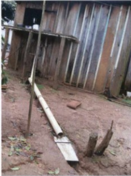
Vista externa da água da pia da cozinha escorrendo a céu aberto. Vista do fogão da cozinha.
