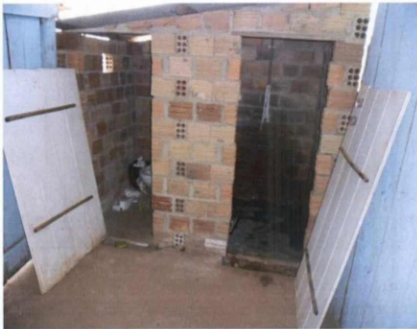
Fig.: Instalações sanitárias no alojamento.
