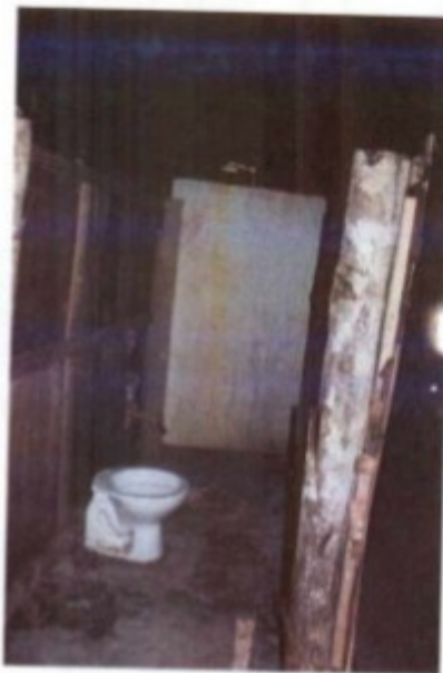
Fotos: instalação sanitária que não estava sendo utilizada por falta de água. Vaso entupido e com fezes acumuladas, sem sinal de uso recente.
