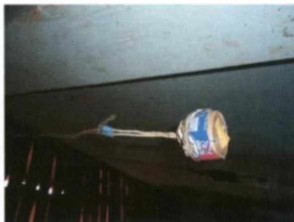
Fotos 1 e 2- Instalações elétricas sem isolamento adequado
