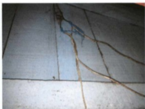
Fotos 1 e 2- Instalações elétricas sem isolamento adequado
