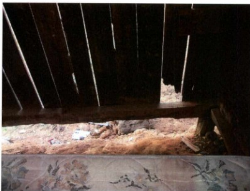
Foto 7: Detalhe da fresta existente no quarto de dormir
