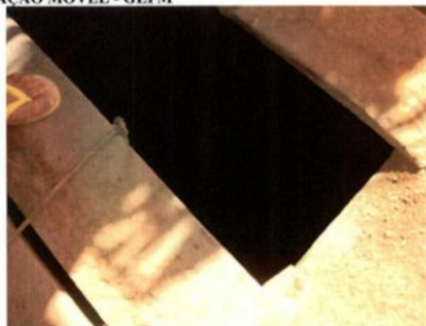
Poço de aproximadamente 25 metros.
