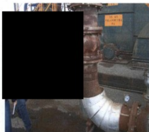
Dutos aquecidos isolados c/ proteção s/manutenção
