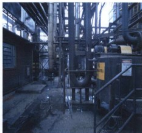
Tubulação aquecida isolada por guarda corpo
