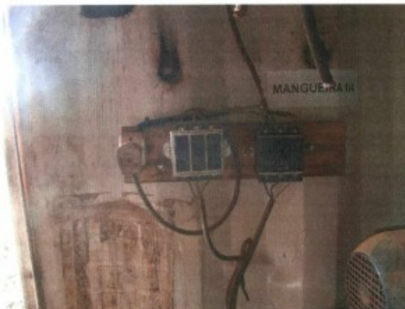
Foto 1- Fiação elétrica não acondiciona em eletroduto-fiação exposta com risco de choque elétrico
