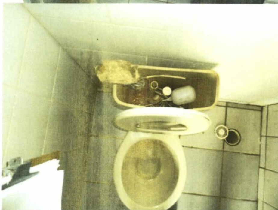
Instalação sanitária sem lavatório, papel higiênico e com descarga danificada.
