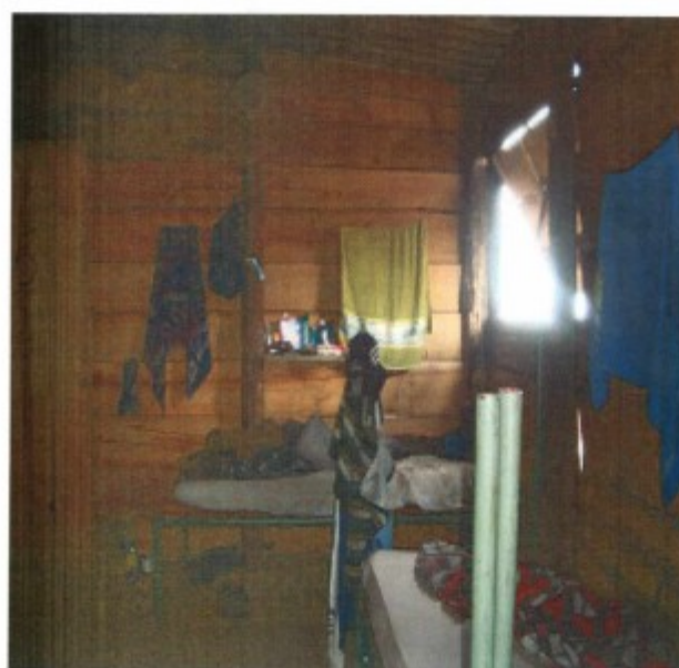
Precariedade do alojamento -14-05-2013
