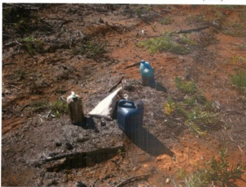
Fornecimento de água não potável em local inadequado para armazenamento na frente de trabalho
