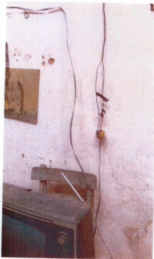
Instalações elétricas da casa desprotegidas e em condições precárias.
