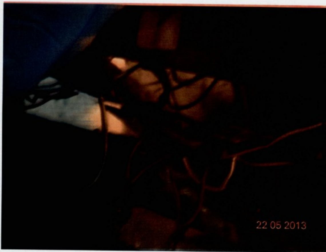
Fiação elétrica exposta, gerando grave risco de choque no interior do estabelecimento
