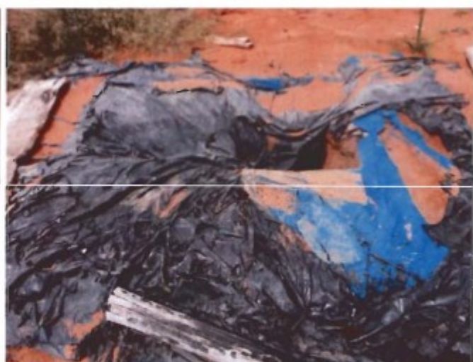
Poço seco sem tampa utilizado como fossa séptica
