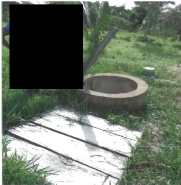
Fig.: Poço anilhado de onde trabalhador coletava água.
