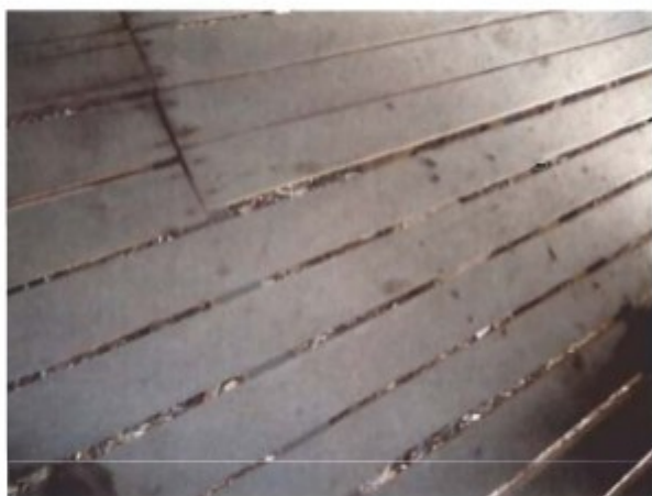
Fotos 28 e 29: ausência de janelas com vedação e piso com frestas.
