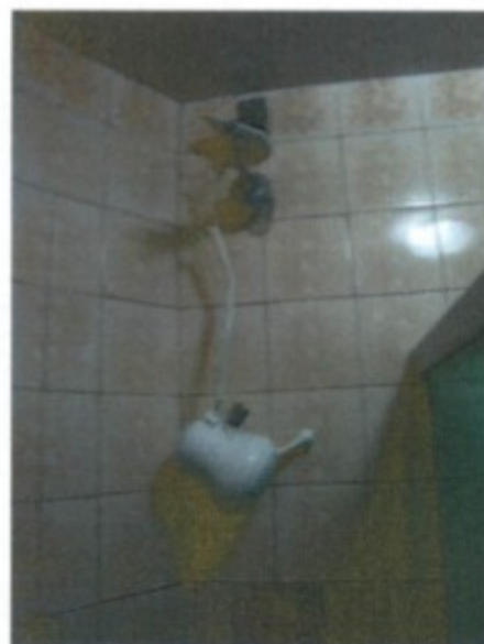
Chuveiro com água fria.
