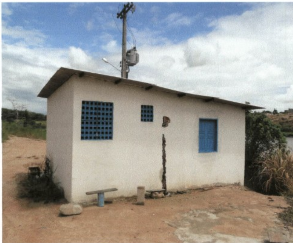
(VISTA GERAL DA CASA - PARTE POSTERIOR - COM CORTES NA PAREDE ONDE FOI INSTALADO O CHUVEIRO, SEM REBOCO COBRINDO A ABERTURA)
