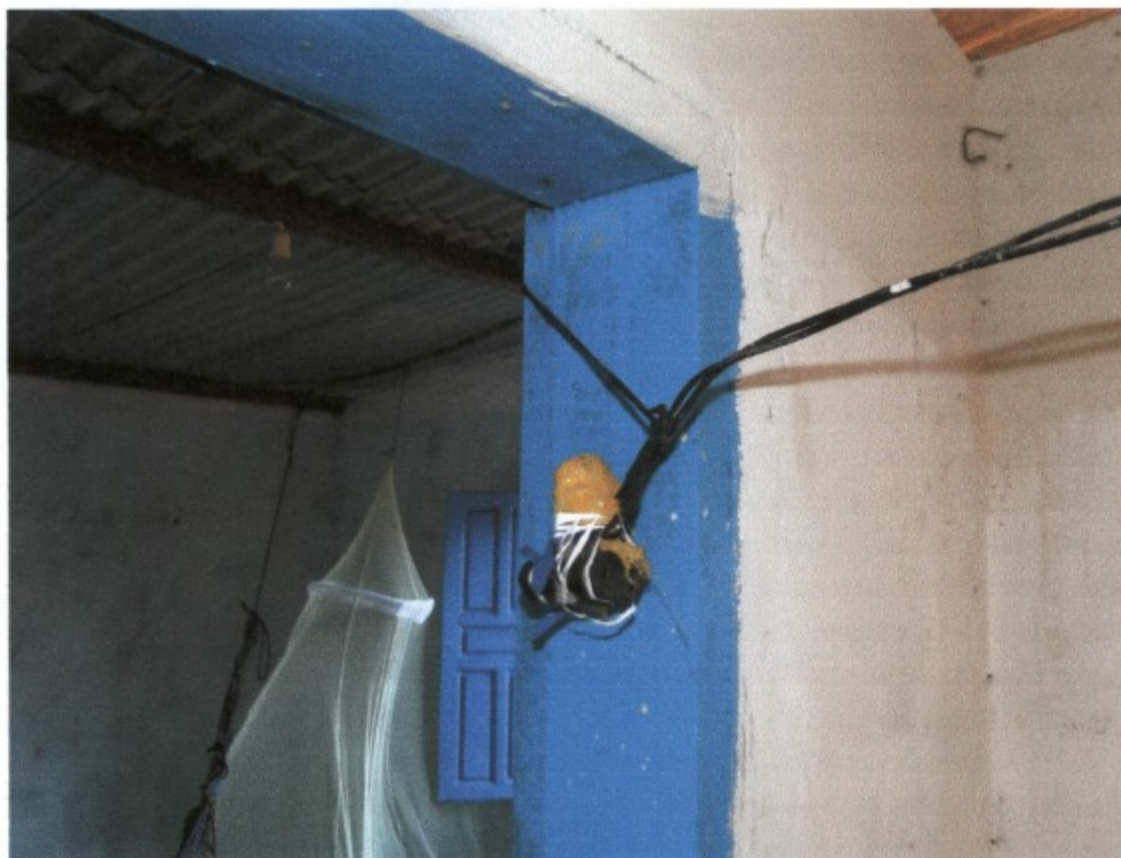
(GAMBIARRA NA REDE ELÉTRICA - INTERIOR DA CASA)
