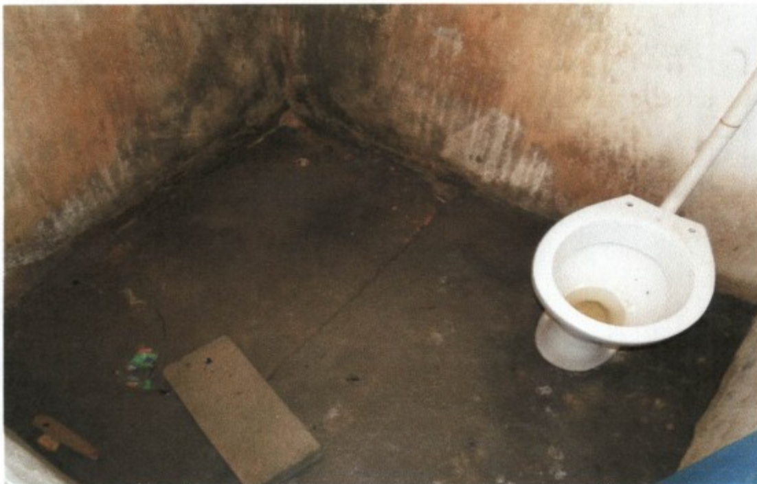
(PISO, VASO DO BANHEIRO SEM REVESTIMENTO IMPERMEÁVEL E HIGIENE ZERO)
