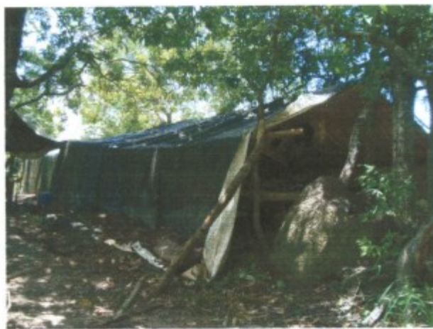
Imagem 06 – vista externa dos alojamentos destinados aos trabalhadores
