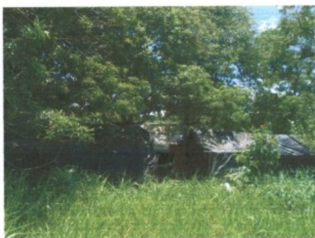
Imagem 05 – vista externa dos alojamentos destinados aos trabalhadores
