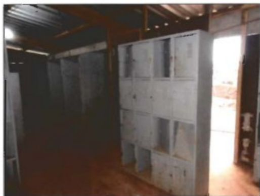
Interior da instalação sanitária - [REDACTED]
