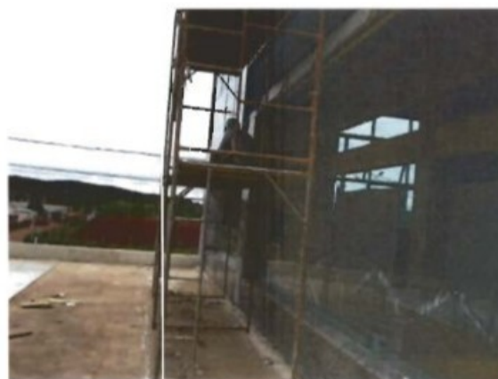
ANDAIME FACHADEIRO SEM GUARDA CORPO, RODAPÉ E TEIA
