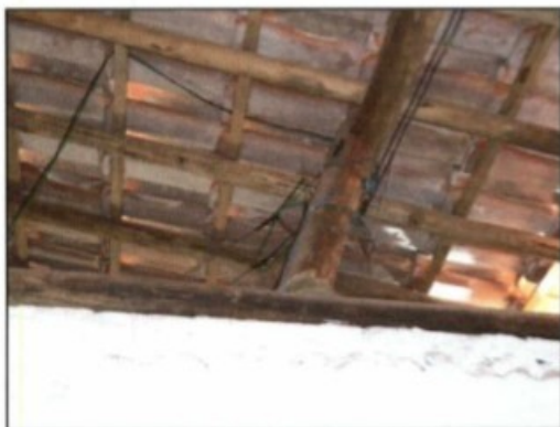
Fotos ilustrativas das instalações elétricas improvisadas da casa, com várias emendas e derivações precariamente isoladas, realizadas sem qualquer dimensionamento ou projeto.
