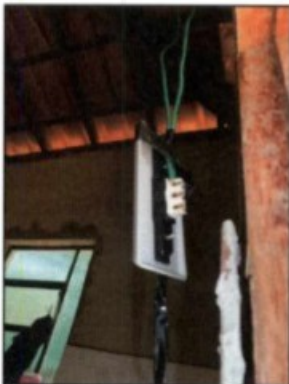
Fotos exemplificativas de improvisações nas instalações elétricas, com partes vivas expostas e emendas precariamente isoladas.
