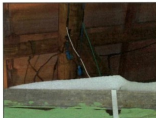
Fotos ilustrativas das instalações elétricas improvisadas da casa, com várias emendas e derivações precariamente isoladas, realizadas sem qualquer dimensionamento ou projeto.
