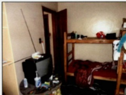
Dormitório com dois beliches, sem as áreas mínimas exigidas em norma, com a porta obstruída.
