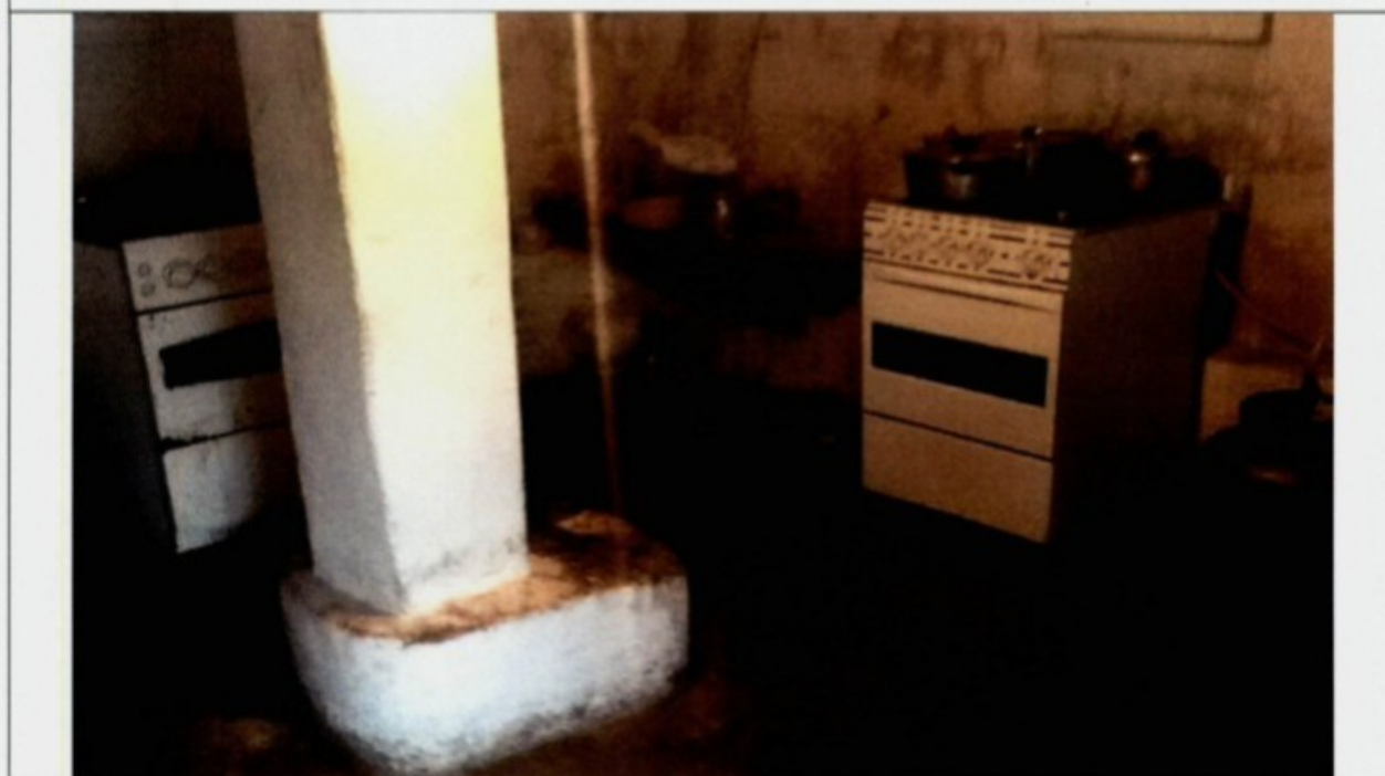
Foto 09: Cozinha sem piso lavável, paredes sujas e com a presença de diversos fogões com botijões de Gás Liquefeito do Petróleo (GLP) no seu interior.
