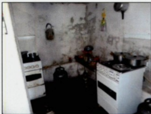
Uma das cozinhas montadas em cômodo improvisado (aparentemente uma antiga instalação sanitária), em precário estado de conservação e limpeza, sem revestimento nas paredes e piso.
