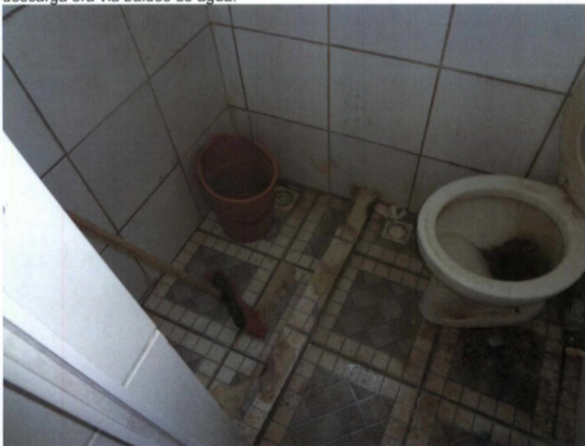
Sanitário sem descarga da Casa Verde.
