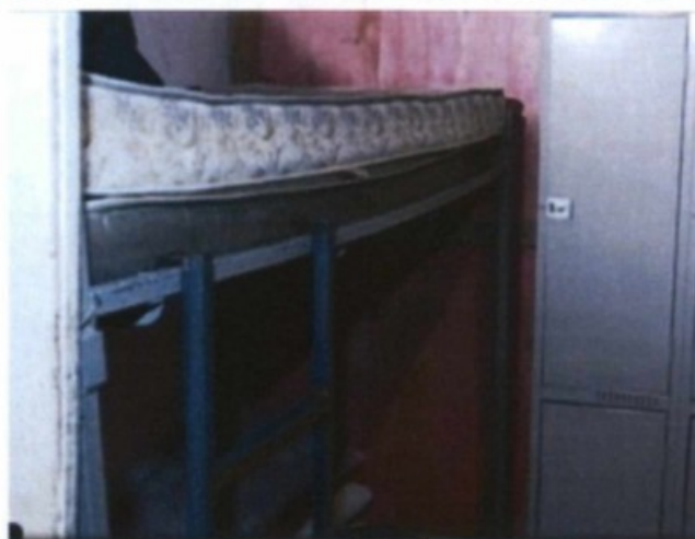
quartos sem ventilação.
