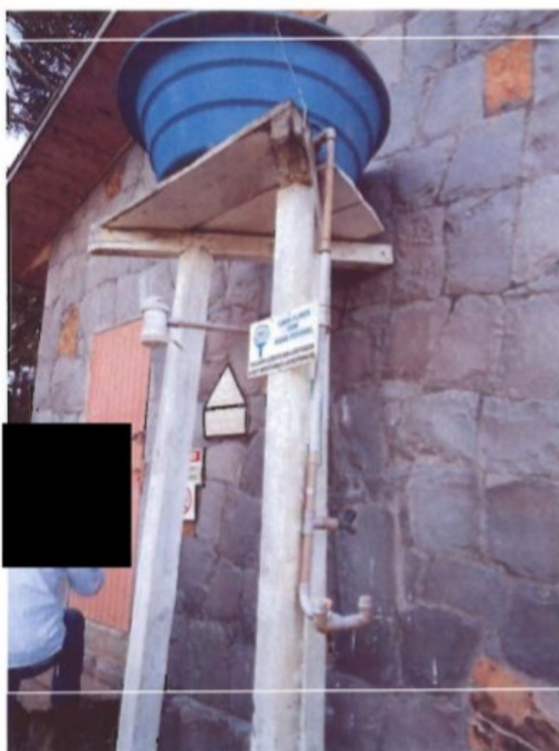
Esq: sistema de lava olhos que não estava funcionando no depósito. Dir: torneira com defeito na edificação para manipulação de agrotóxicos.
