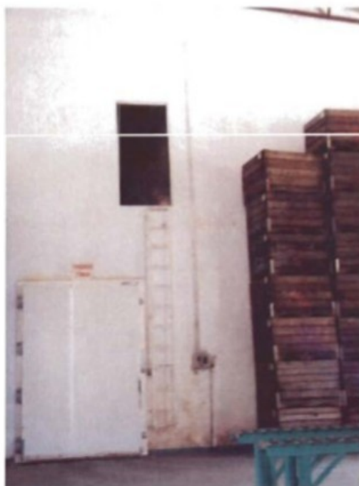
Escada a mais de 3,50 do solo, sem proteção contra quedas.
