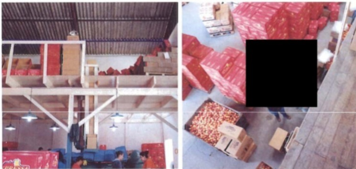
Não havia proteção contra queda em toda a extensão da parte superior do galpão
