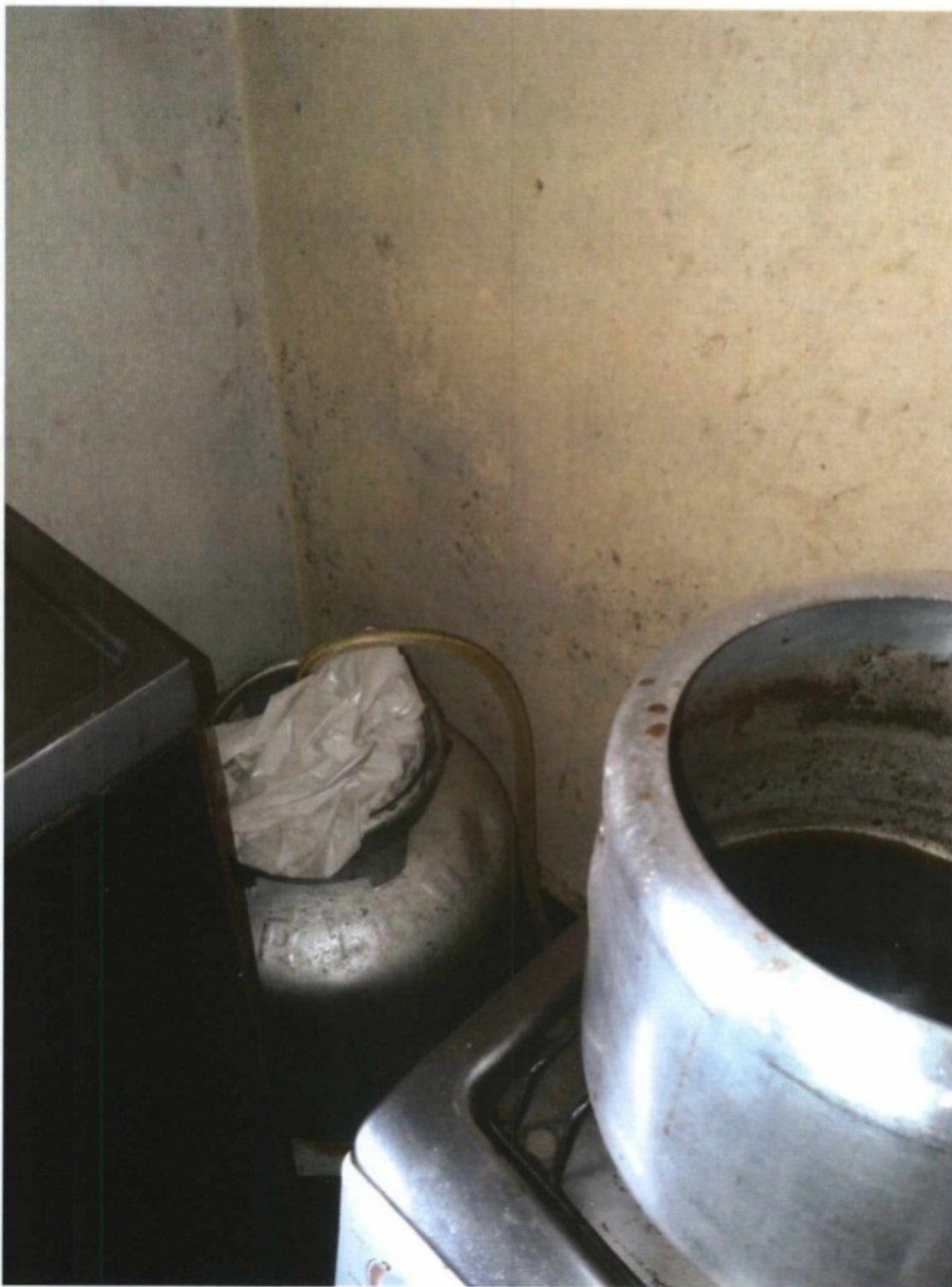
Alojamentos Jardim [REDACTED] – botijão de gás em local inadequado – risco grave e iminente de explosão
