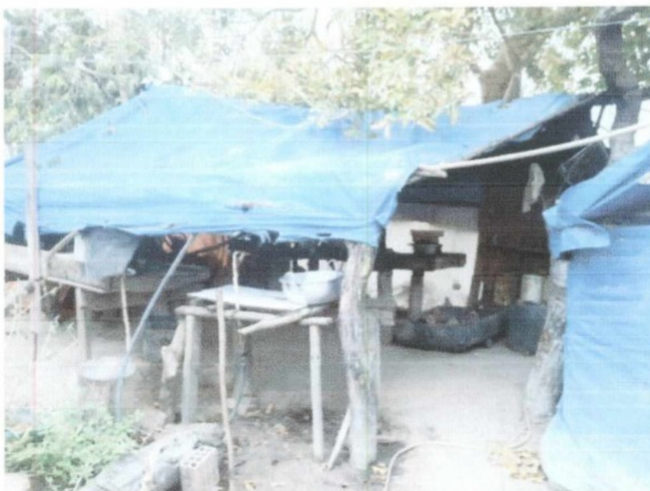
Local de refeições ao lado do alojamento – Fazenda Piúva
