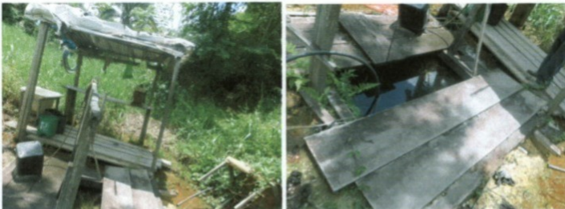
Poço desprotegido contra contaminação
