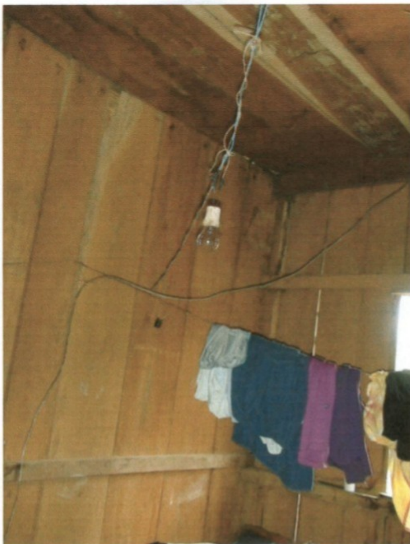
Lâmpada sem interruptor para ligação
