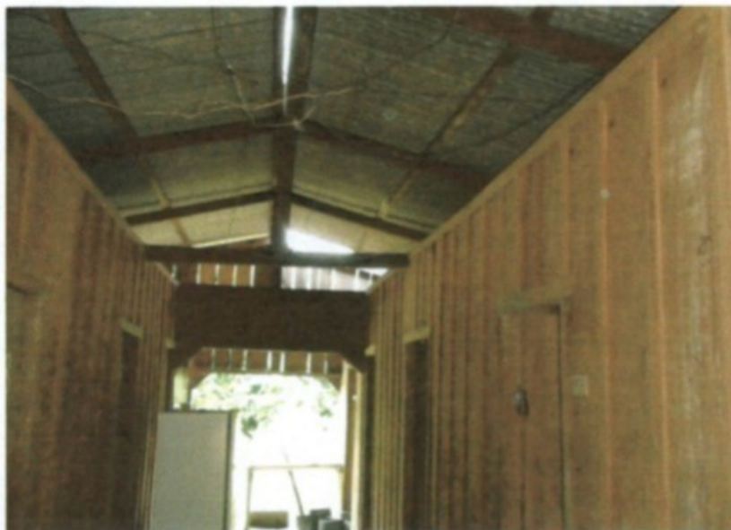
Fiação elétrica desprotegida
