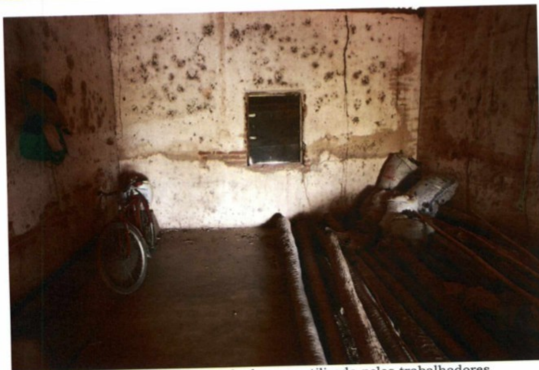
Fotos 2, 3 e 4: Primeiro cômodo da casa utilizada pelos trabalhadores
