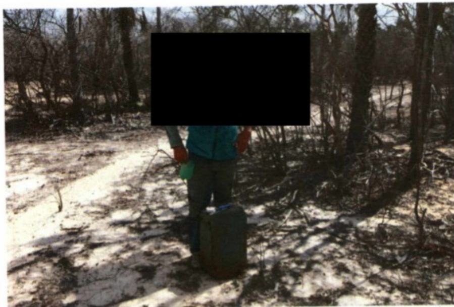
Fotos 32, 33 e 34: Trabalhadores na frente de serviço. Na foto 34, pode ser vista o galão como depósito d'água e o copo coletivo feito de garrafa "pet".
