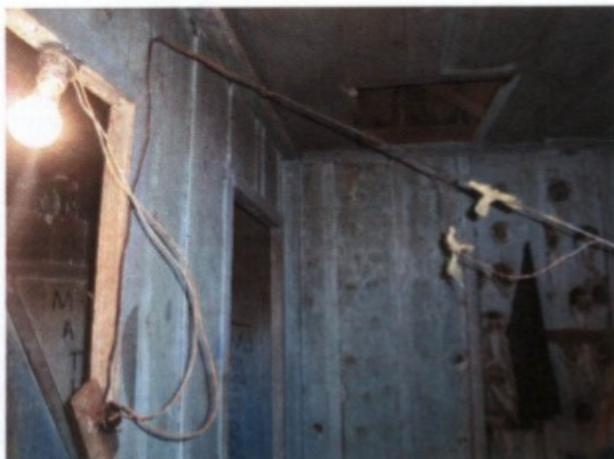
Improvisação: Sacola plástica para isolar instalações elétricas.
