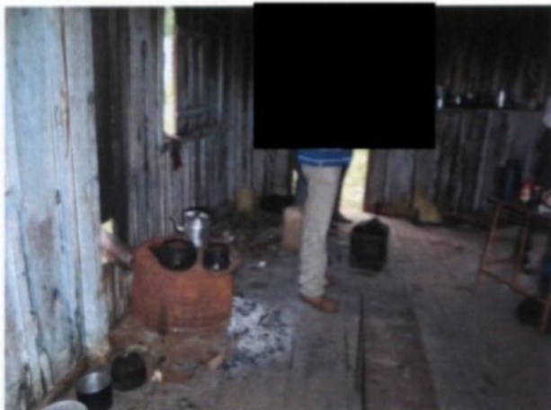
Risco evidente: fogão de tonel, alimentado por lenha, disposto diretamente no assoalho de madeira.
