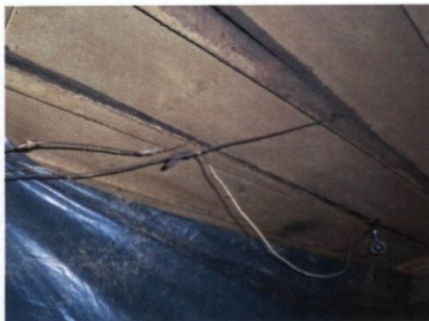
Instalações elétricas sem proteção. Vista do tanque, instalado aos fundos.
