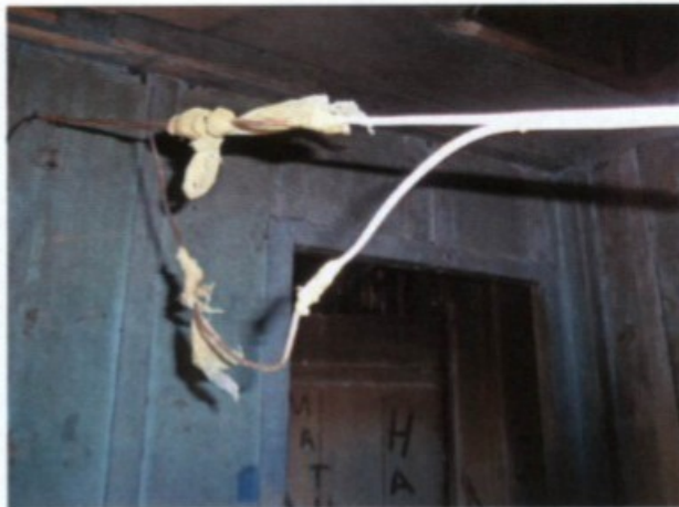
Improvisação: Sacola plástica para isolar instalações elétricas.
