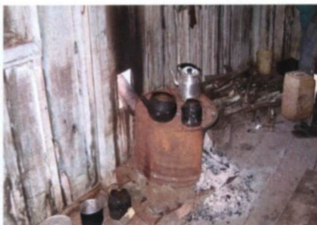
Risco evidente: fogão de tonel, alimentado por lenha, disposto diretamente no assoalho de madeira.
