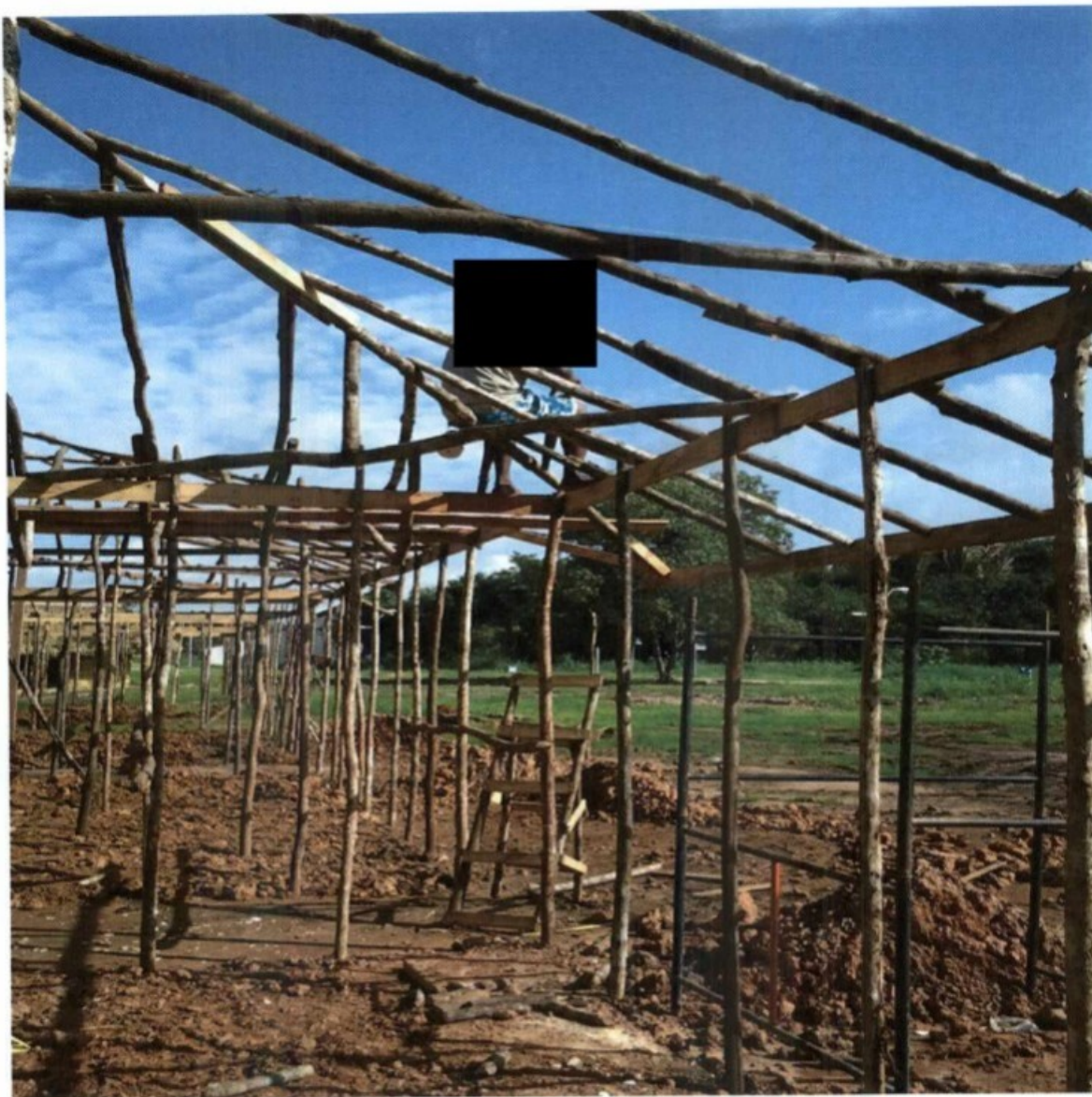
Foto 14 – Empregado laborando, a mais de 2,00 m (dois metros) de altura, sem usar cinto de segurança ligado a cabo de segurança, nem qualquer outro equipamento de proteção individual.
