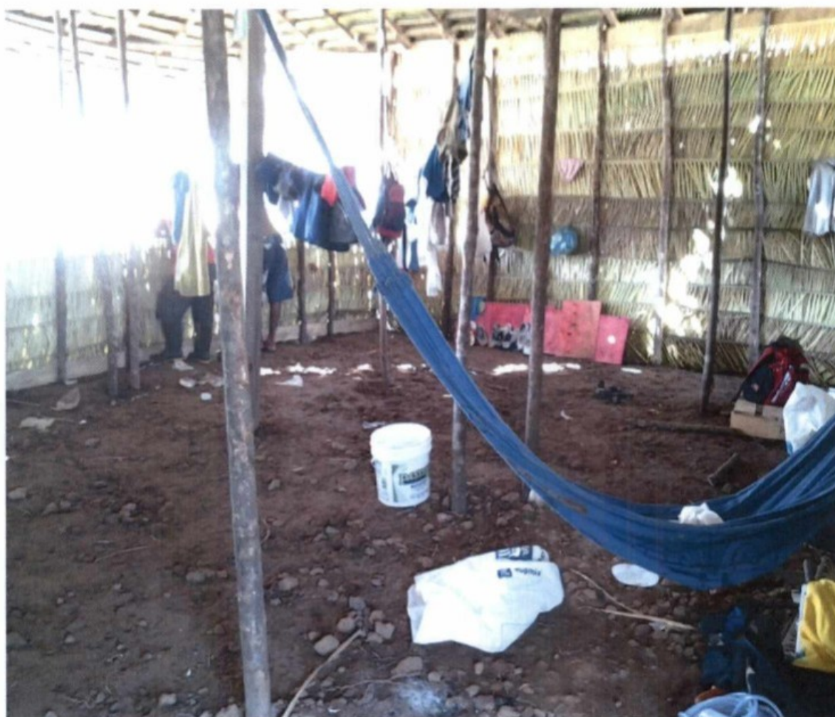
Foto 1 – Alojamento dos trabalhadores com paredes e teto construídos de palhas de babaçu, sem janelas , piso de chão de terra batida e com roupas penduradas em varal.
