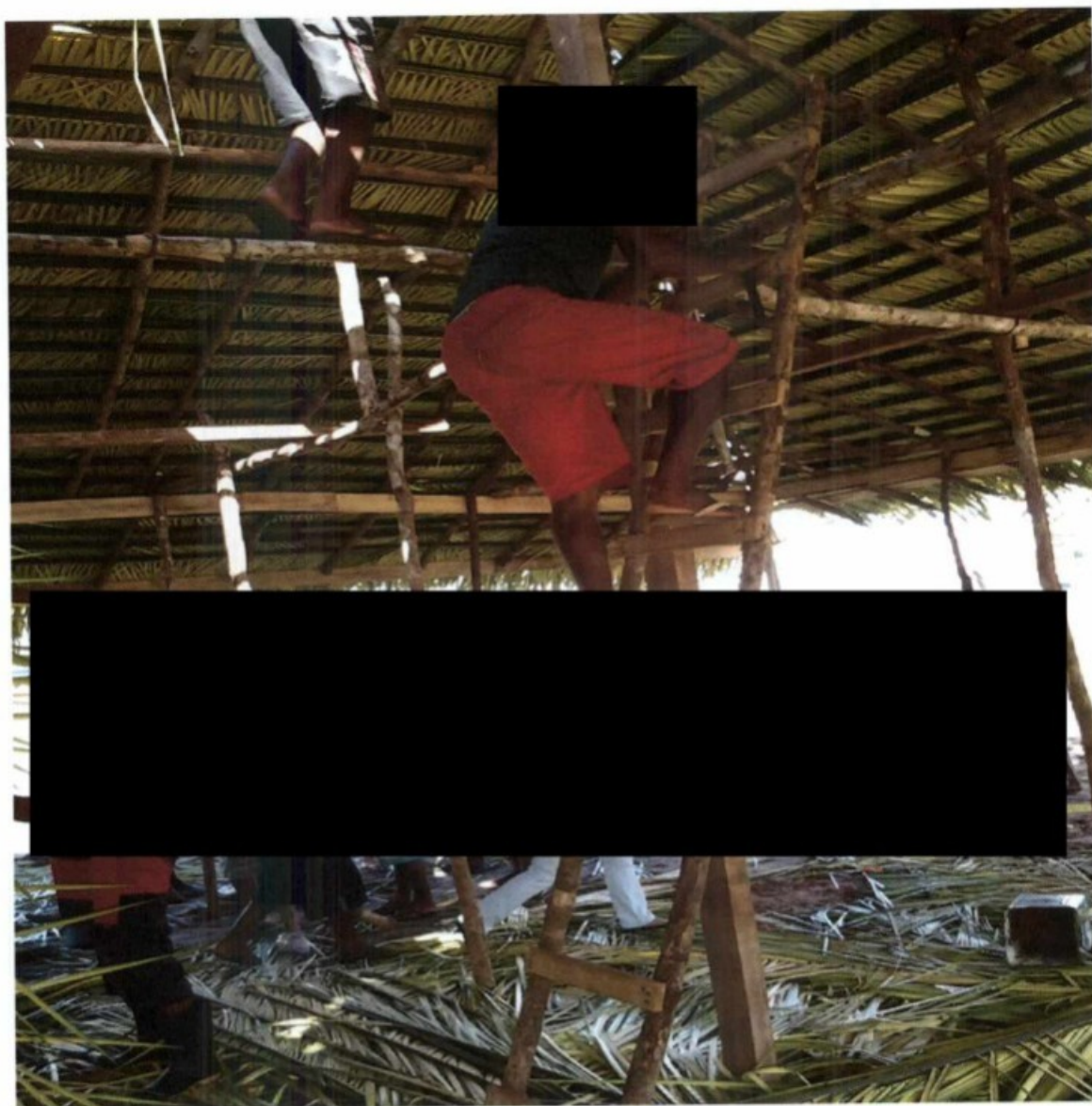
Foto 13 – Empregados laborando, a mais de 2,00 m (dois metros) de altura, sem usar cinto de segurança ligado a cabo de segurança, nem qualquer outro equipamento de proteção individual.
