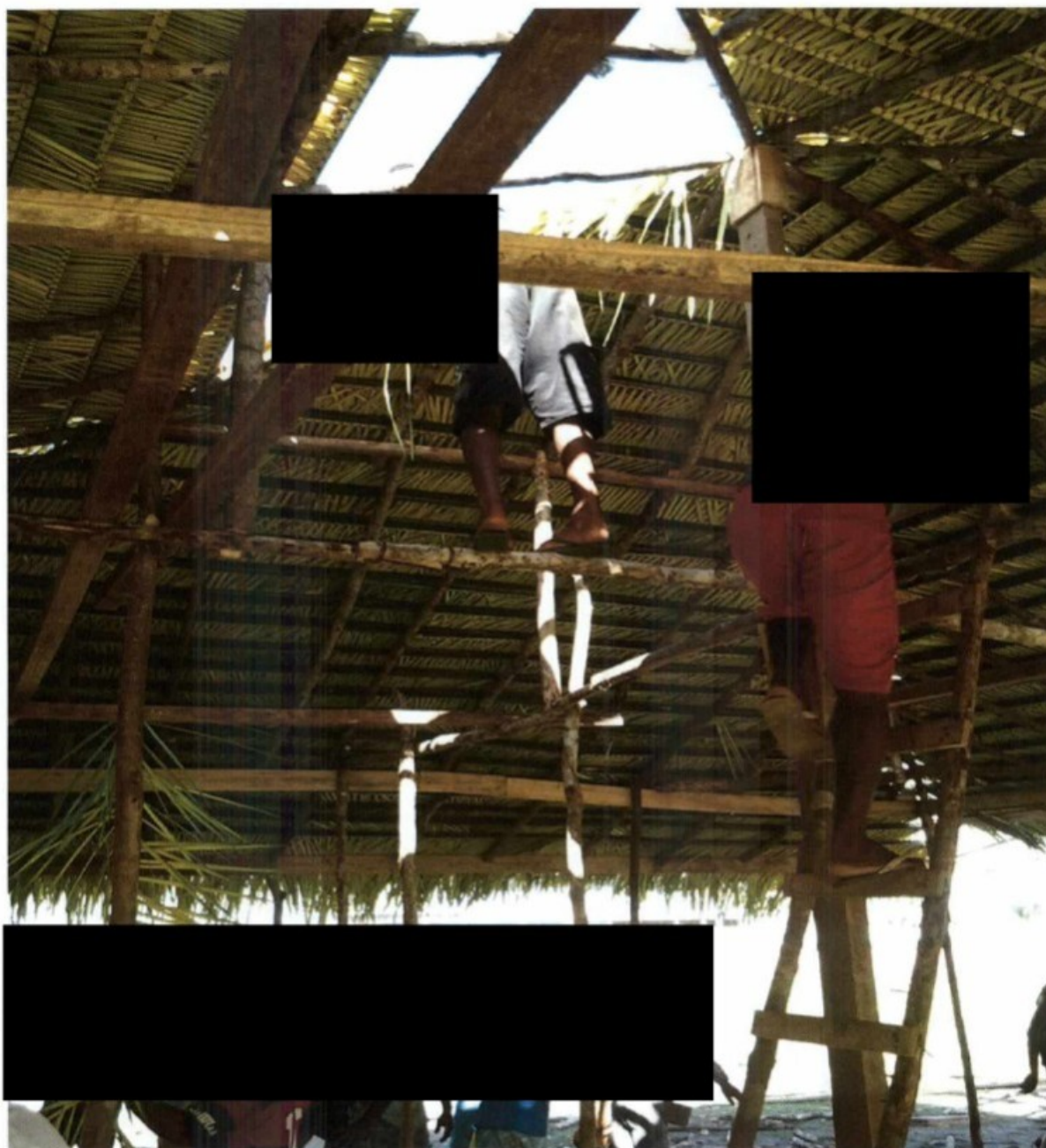
Foto 17 – Empregados laborando, a mais de 2,00 m (dois metros) de altura, sem usar cinto de segurança ligado a cabo de segurança, nem qualquer outro equipamento de proteção individual.
