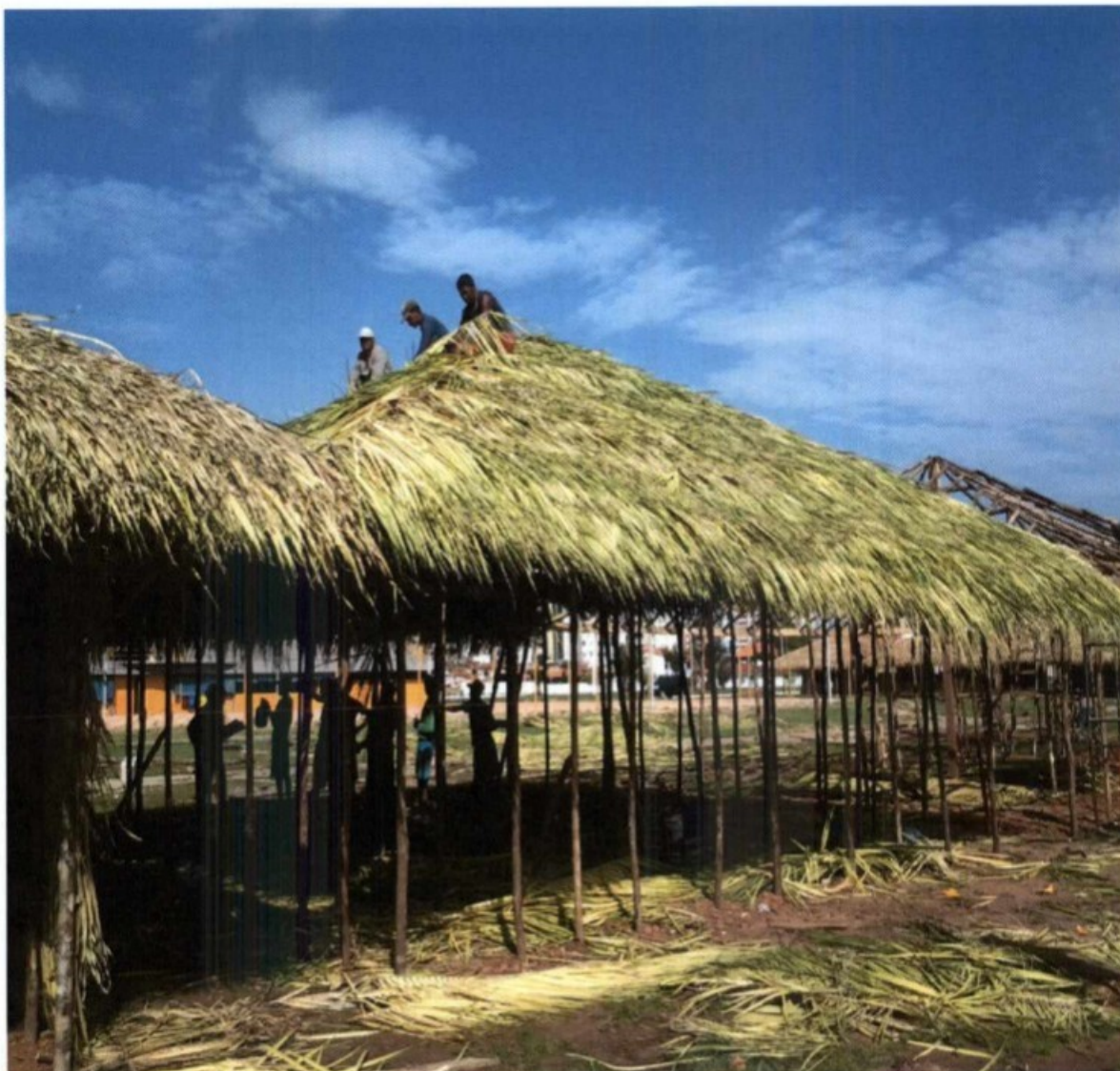
Foto 19 – Empregados laborando, a mais de 2,00 m (dois metros) de altura, sem usar cinto de segurança ligado a cabo de segurança, nem qualquer outro equipamento de proteção individual. Trabalhadores não submetidos a exames médicos admissionais.
