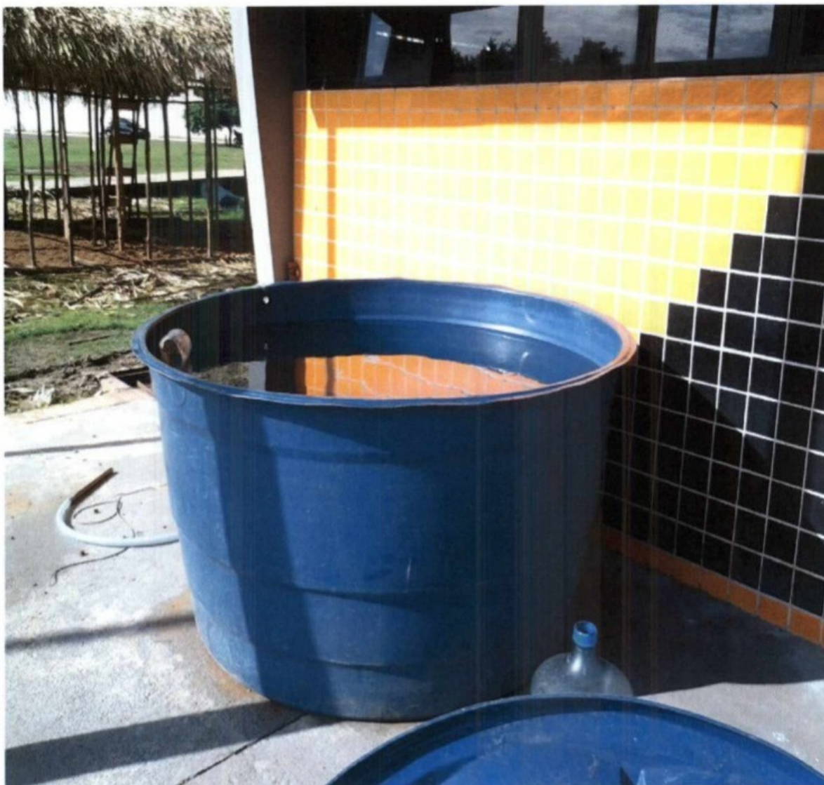
Foto 5 – Água para consumo e asseios corporais dos trabalhadores. Água sem adequadas condições de higiene. Recipiente exposto à poeiras. Não há filtro(s) ou bebedouro(s) na obra. Uso de garrafa “pet”, como copo coletivo.
