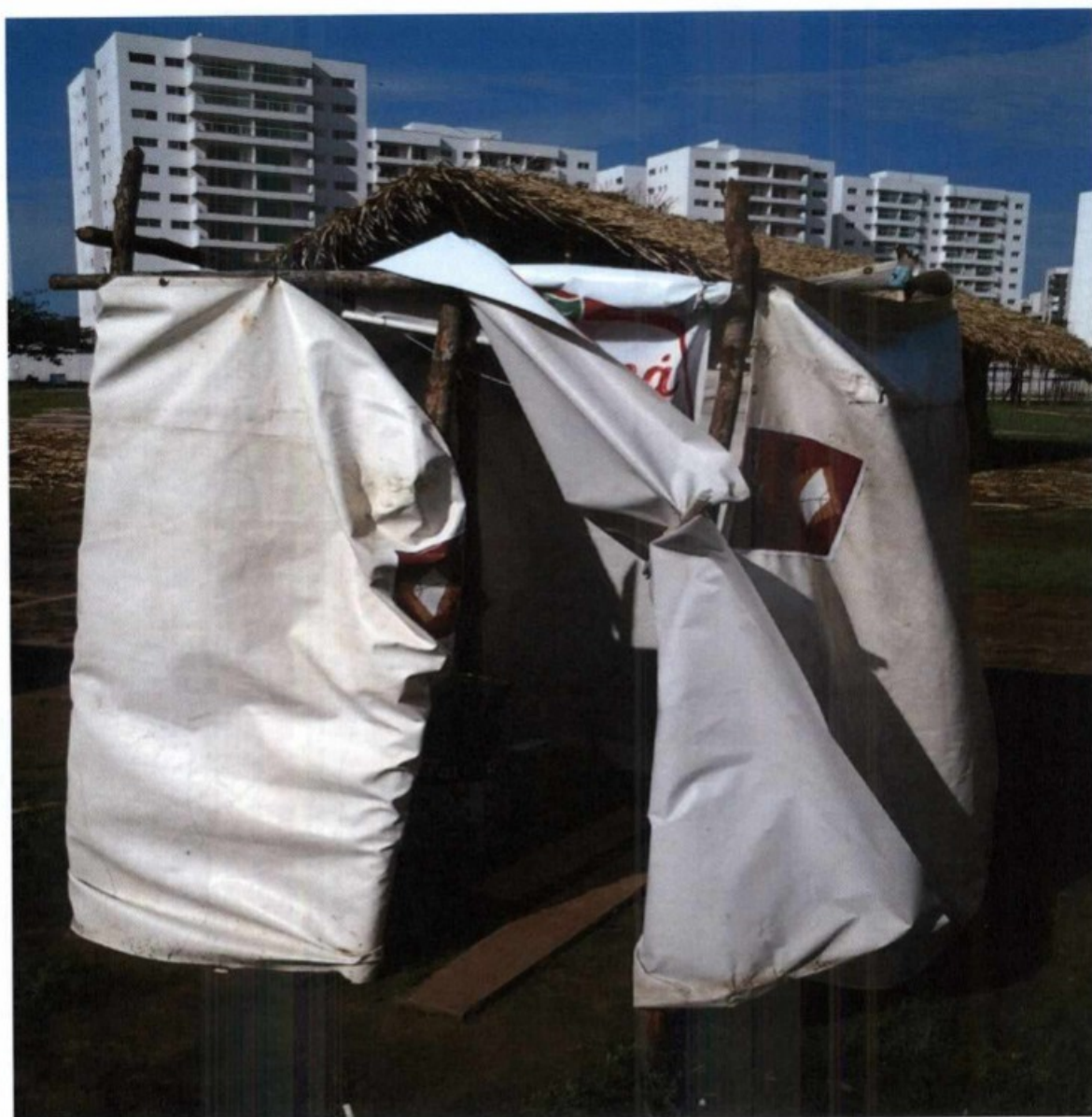
Foto 8 – Local de realização dos asseios corporais dos trabalhadores. Recinto construído com esteios de madeira e envolto por lona plástica branca. Não há resguardo da privacidade dos trabalhadores. Local devassado. Instalação sem teto e sem porta.
