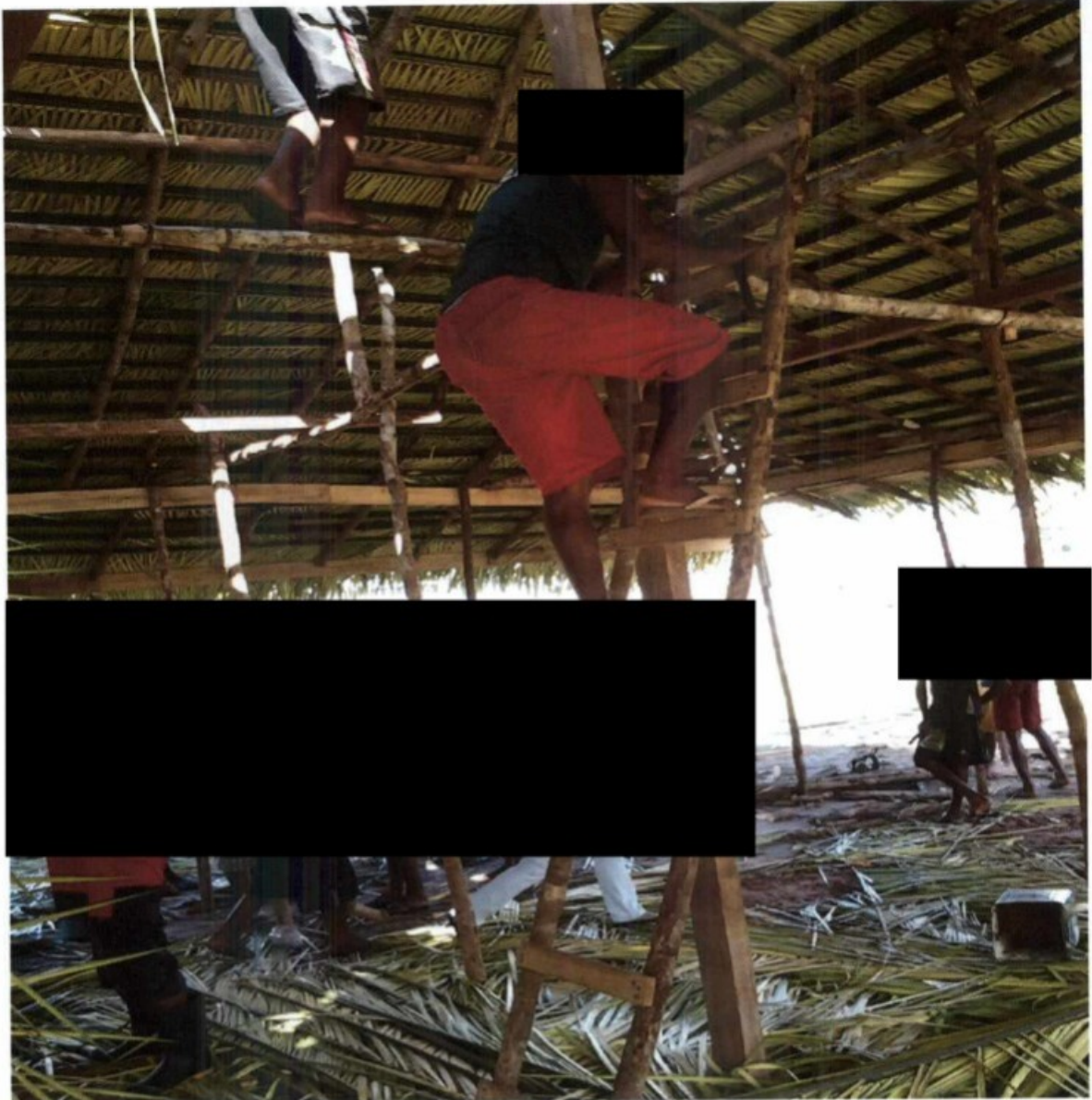
Foto 21 – Empregados laborando, a mais de 2,00 m (dois metros) de altura, sem usar cinto de segurança ligado a cabo de segurança, nem qualquer outro equipamento de proteção individual. Escada de mão sem fixação nas partes inferior e posterior e/ou não dotada de dispositivo capaz de impedir o seu escorregamento.
