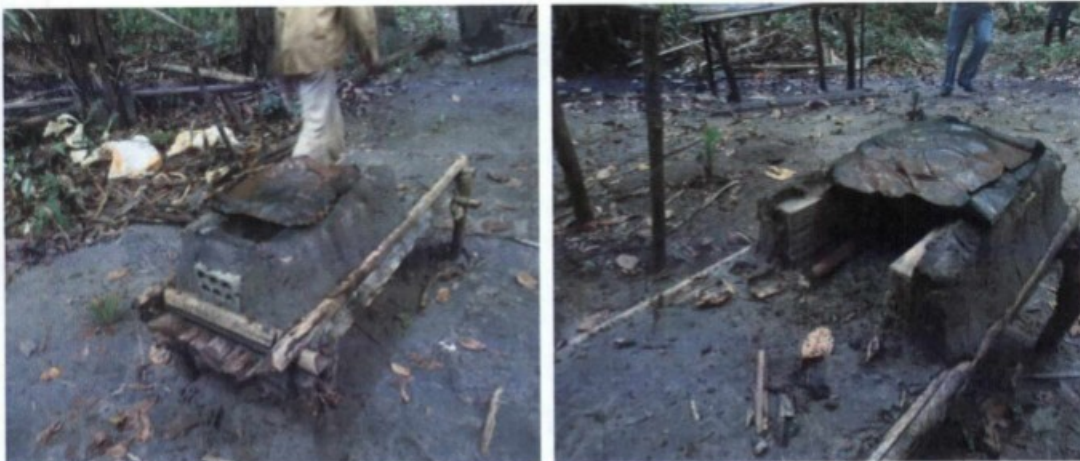
Fogareiro à lenha improvisado com tijolo e barro mantido nos fundos do barraco.
