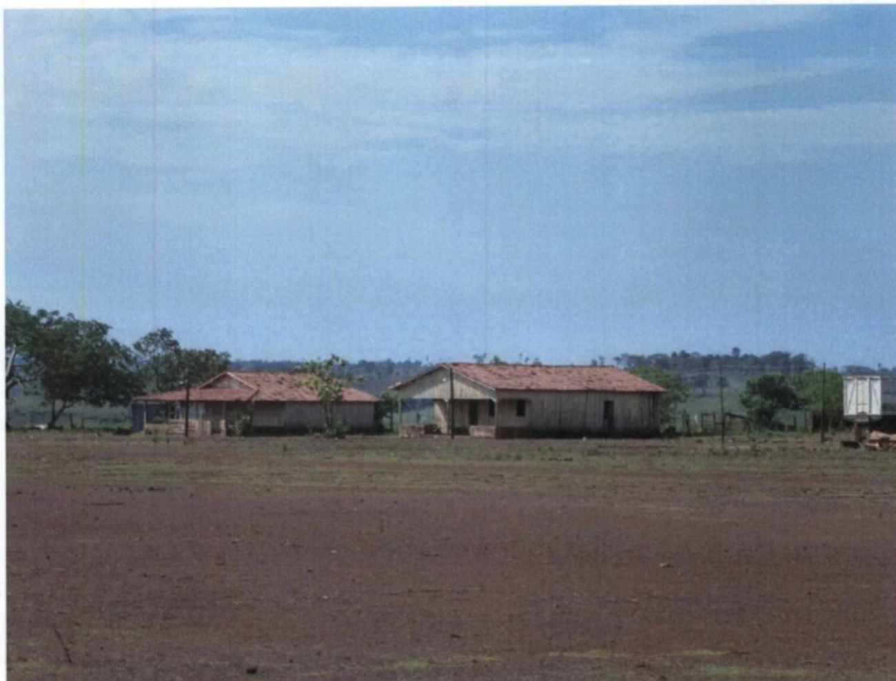
Vista geral das duas casas disponibilizadas aos trabalhadores encontrados pelo GEFM
