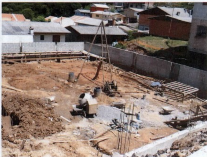
Equipamento utilizado para realização dos serviços de estaqueamento: ausência de proteção nas partes móveis, força de transmissão e motor; ausência, também, de isolamento da área de trabalho.
