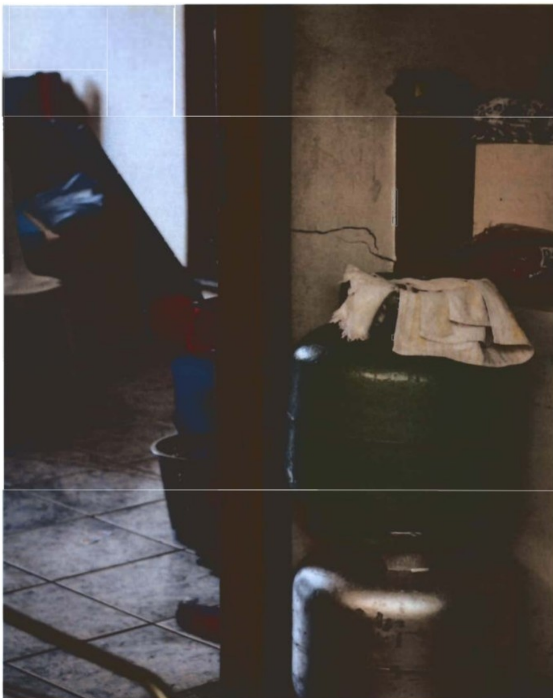
Cozinha e refeitório coletivos – botijão de gás em local não ventilado, próximo a material inflamável – Oficina de Costura
