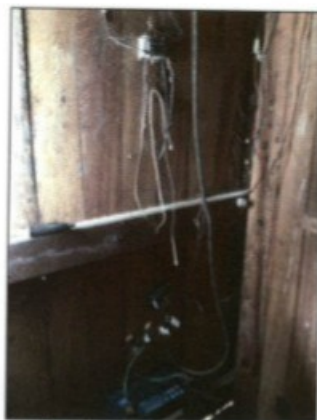
Detalhe das instalações elétricas, com emendas precariamente protegidas e partes vivas expostas.
