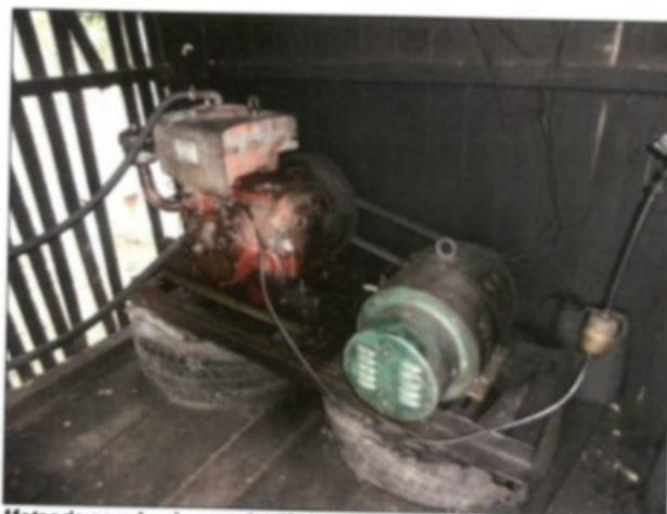
Motor do gerador de energia elétrica com as transmissões de força expostas.
