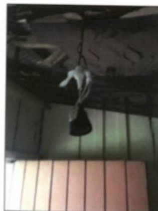
Emendas "isoladas" com pedaços de sacolas plásticas.
