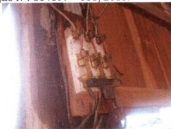
Foto: Chave Seccionadora Tipo-faca instalada sem caixa de isolamento e com terminais expostos.
