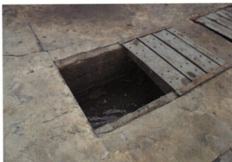
Fig.: Abertura no piso desprotegida.
