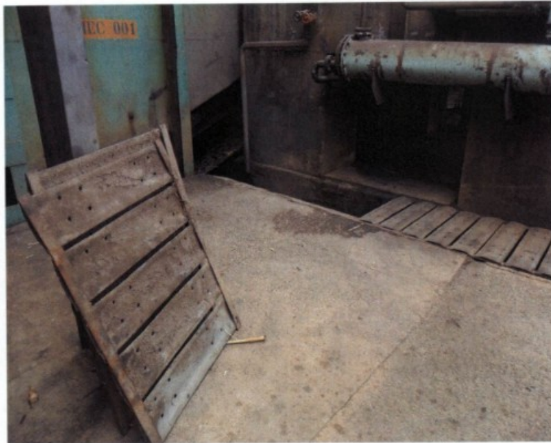
Fig.: Abertura no piso desprotegida.
