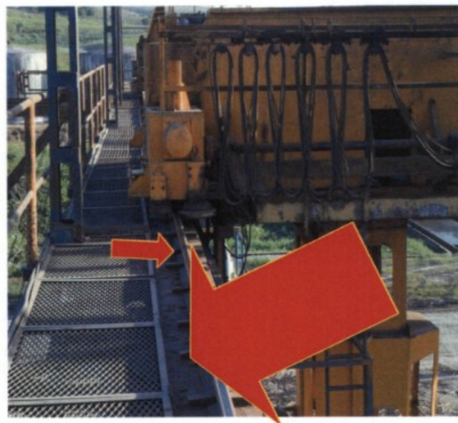
Fig.: Rampa que liga moenda à caldeira sem guarda corpo na lateral direita e ângulo superior a 20 graus.
