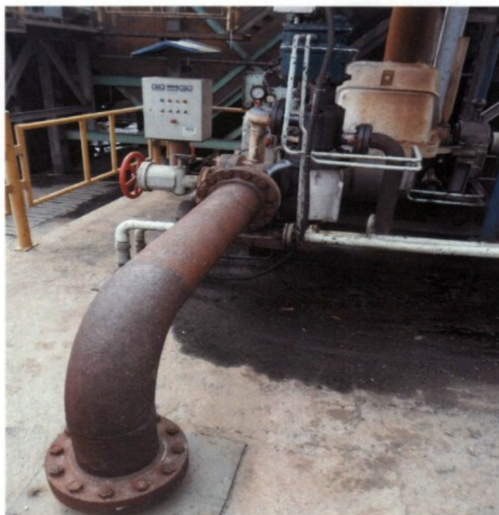
Fig.: Joelho de tubulação transportando fluidos aquecidos sem proteção contra queimaduras.
