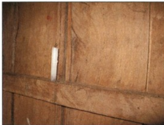
iluminação precária e com risco de incêndio
