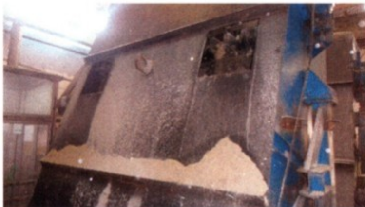
Foto 17: falta de proteção de particulados
