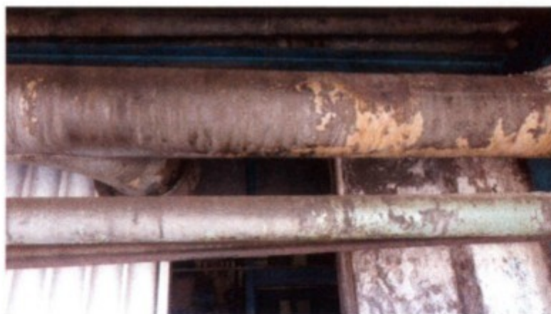
Foto 18: falta de sinalização
