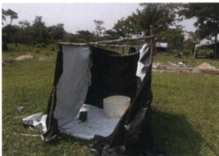
Fig. 5: Barraco utilizado como banheiro por trabalhadores.
