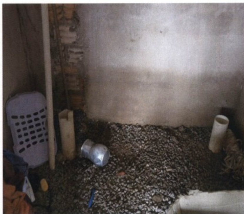
Fig.: Cômodo utilizado pela cozinheira para banhar-se e a seus filhos.
