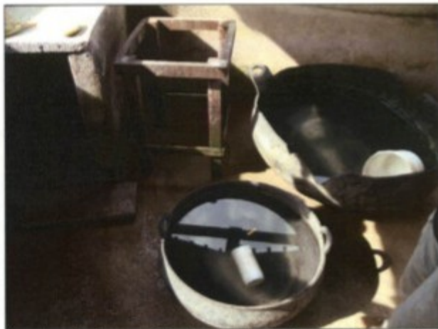
Área de estrutura semi-aberta, com laterais de alvenaria com altura máxima de 1,60m, sem porta, com água "armazenada" em câmaras de pneus, sem qualquer privacidade e conforto, usada por todos para banhos, lavação de roupas e, até mesmo, para micção pelas mulheres.
