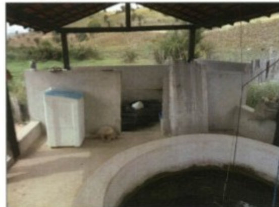
Estrutura semi-aberta, construída em torno de poço, única fonte de água disponível (para beber, cozinhar e higienizar), sem tampa, acessível a animais e sujeito a poeira e outras sujidades, dividida em duas partes por diferença de nível e tendo como "porta" entre elas um mero pedaço de telha metálica, sendo a área de baixo usada para banho, lavagem de roupas e para ato miccional pela "cantineira".
