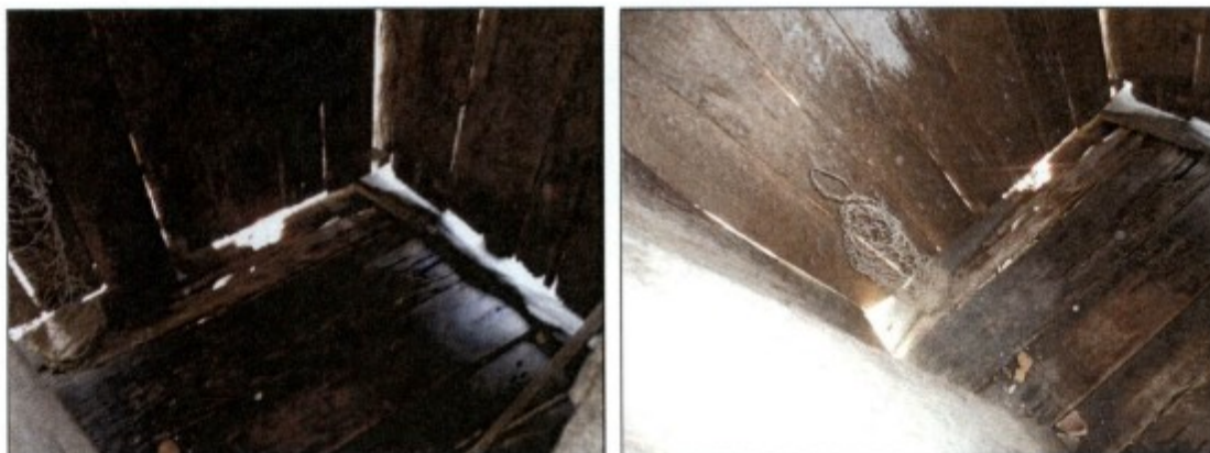
Aspectos internos das instalações sanitárias – banheiro -
