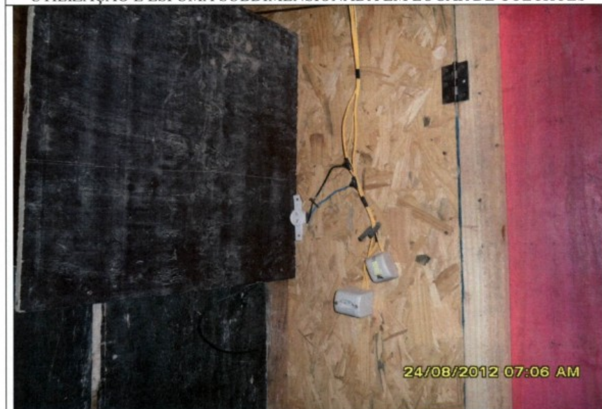
GAMBIARRA DE INSTALAÇÕES ELÉTRICAS – RISCO DE INCÊNDIO
