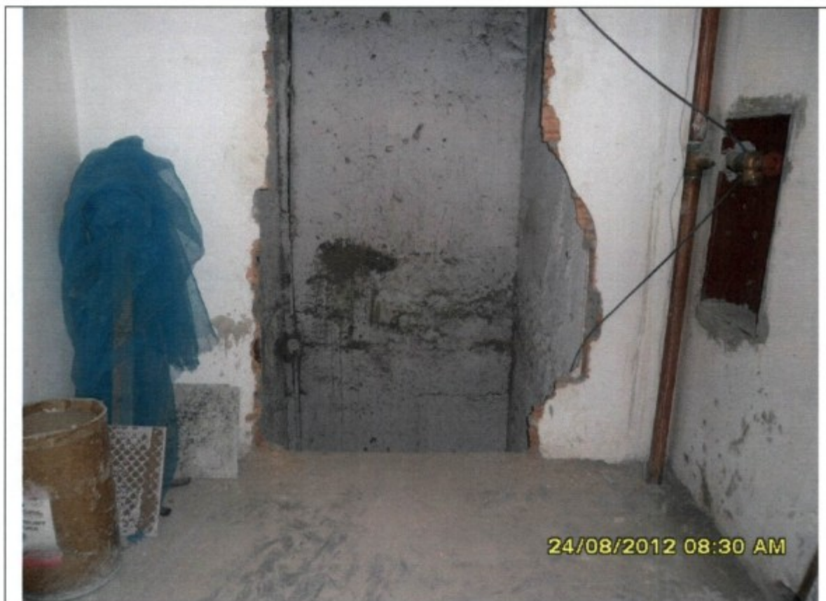
AUSÊNCIA DE PROTEÇÃO FIXA NOS VÃOS DE ACESSO À CAIXA DO ELEVADOR DEFINITIVO
