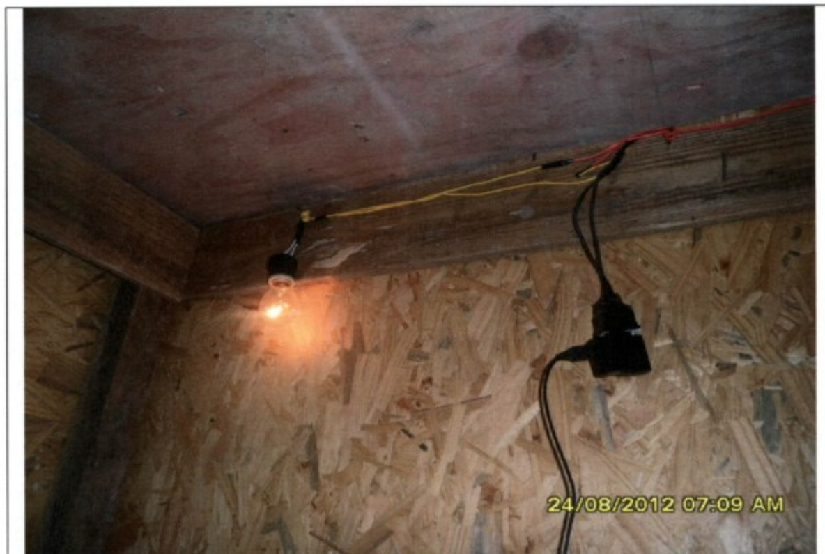
INSTALAÇÕES ELÉTRICAS PRECÁRIAS DENTRO DA CAMA-CAIXOTE COM RISCO DE CHOQUE ELÉTRICO E INCÊNDIO
