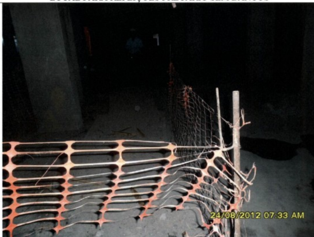
PONTAS VERTICAIS DE VERGALHÕES DESPROTEGIDAS COM RISCO DE ACIDENTES
