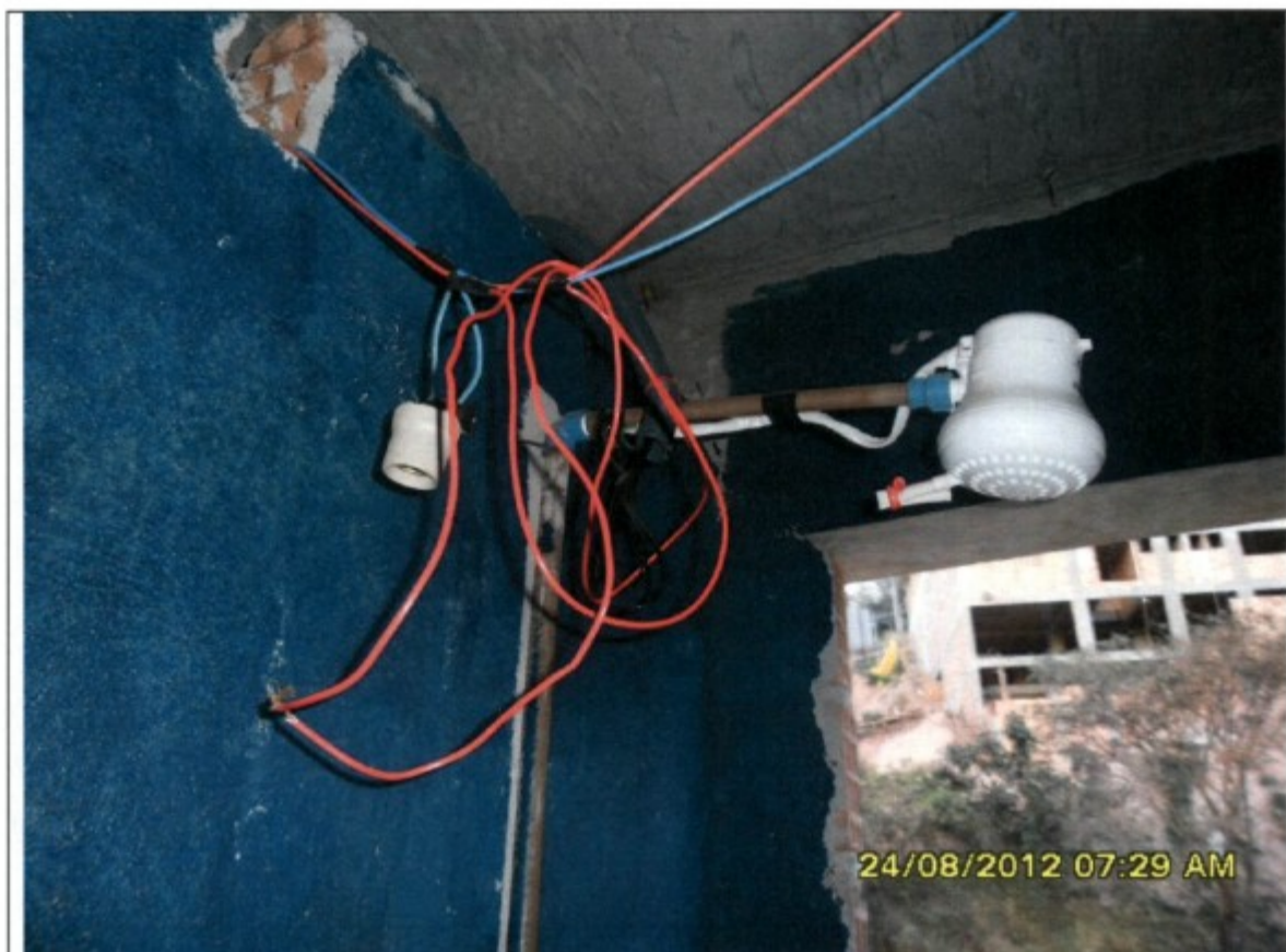
INSTALAÇÕES ELÉTRICAS PRECÁRIAS
