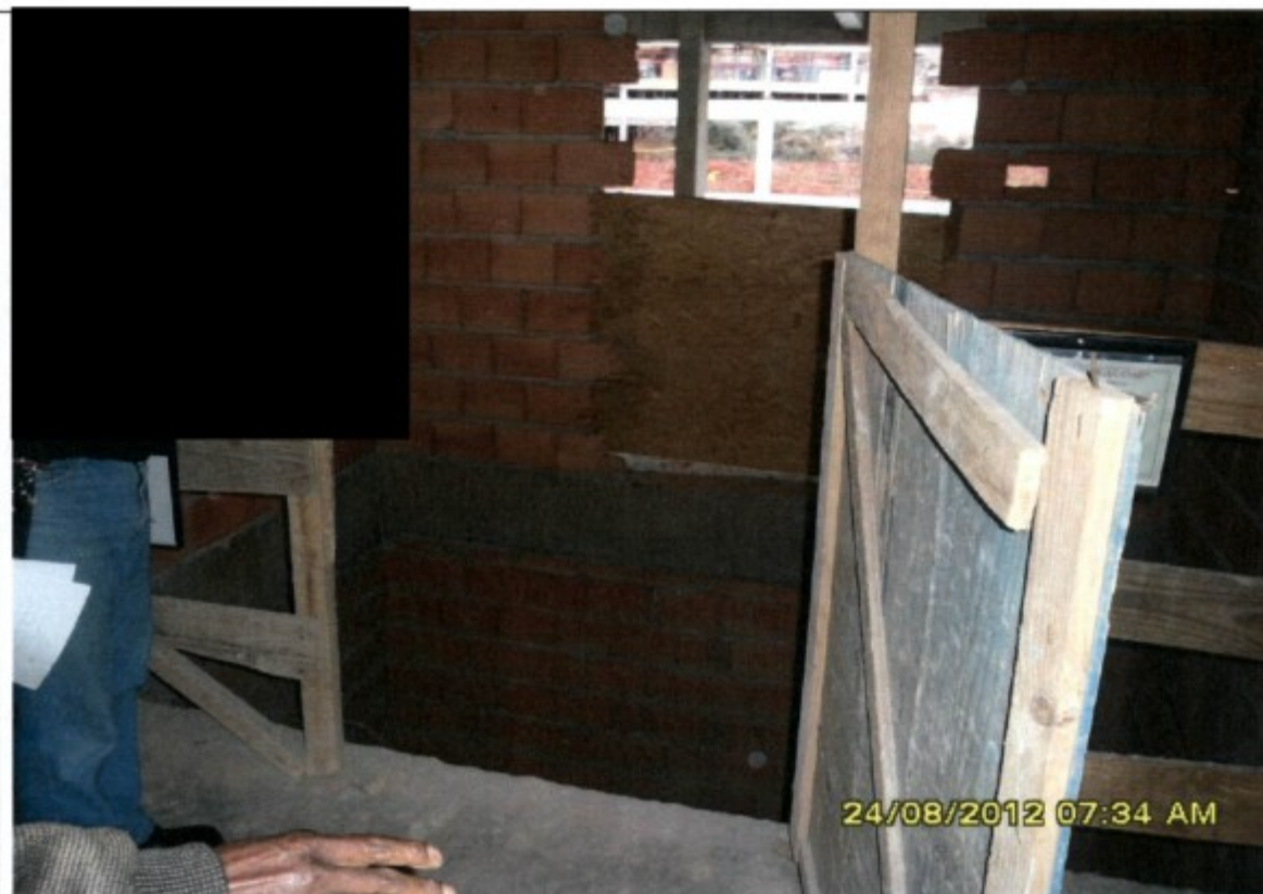
AUSÊNCIA DE GUARDA-CORPO FIXO NOS PONTOS DE ENTRADA E SAÍDA DE MATERIAIS – FOSSO DO ELVADOR DEFINITIVO
