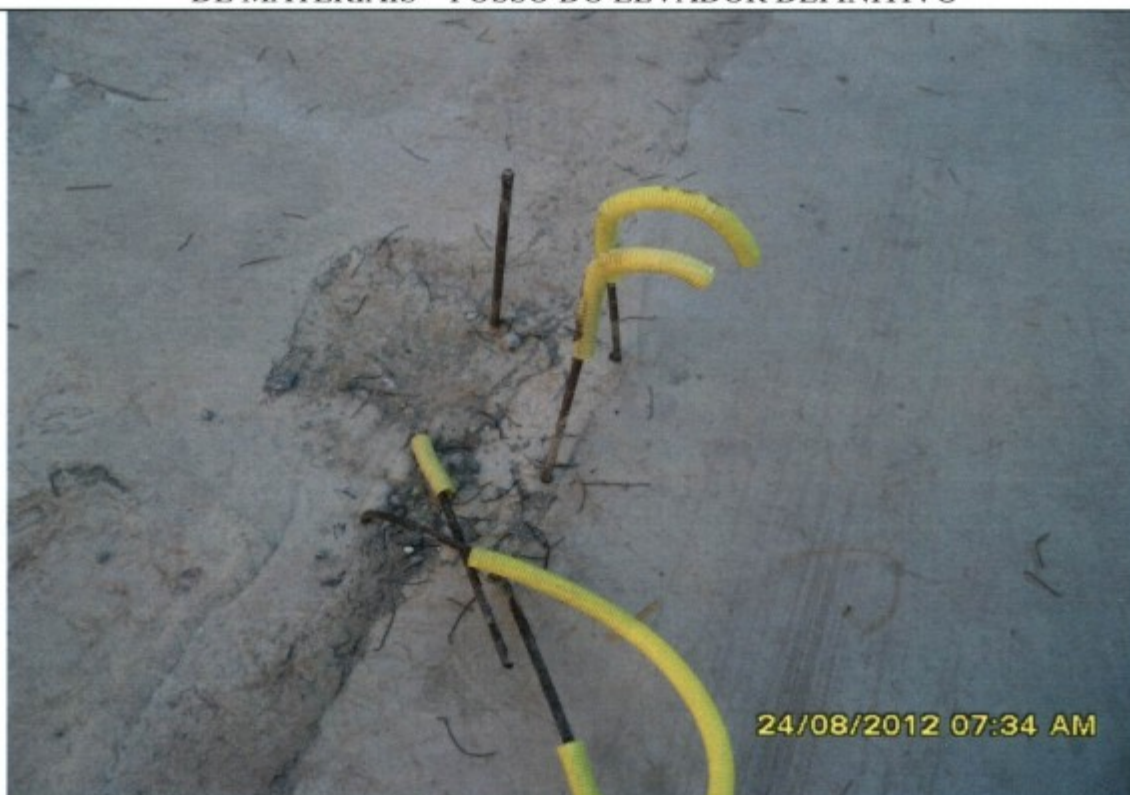
PONTAS VERTICAIS DE VERGALHÕES DESPROTEGIDAS COM RISCO DE ACIDENTES
