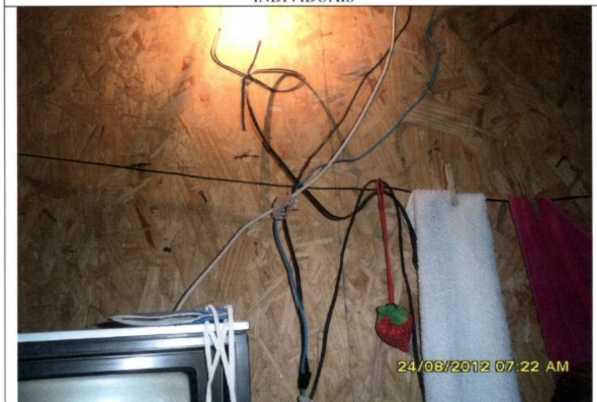
GAMBIARRA ELÉTRICA DENTRO DA CAMA-CAIXOTE – RISCO DE CHOQUE ELÉTRICO E INCÊNDIO
