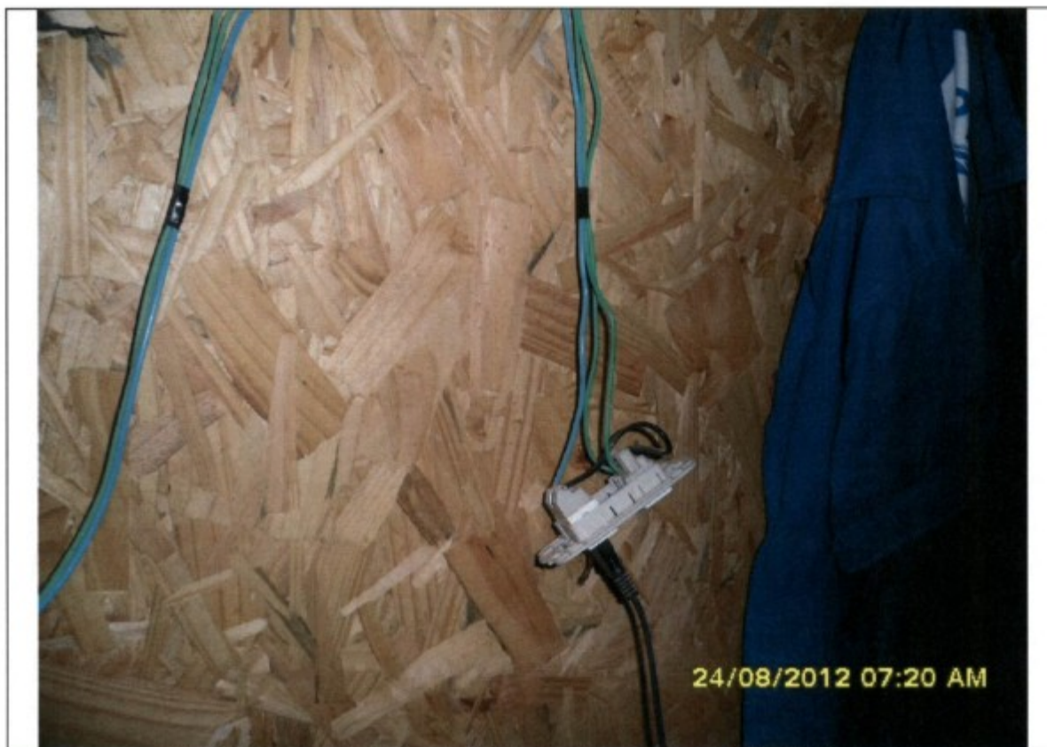
GAMBIARRAS ELÉTRICAS DENTRO DA CAMA-CAIXOTE
