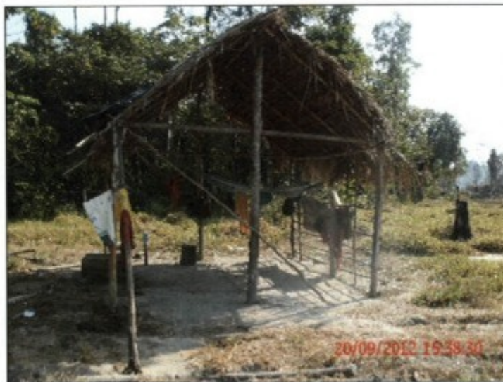
Estrutura rústica de toras e palha utilizada como "alojamento" de trabalhadores: sem proteção contra intempéries e contra acesso de animais, piso de terra, sem iluminação, sem armários.
