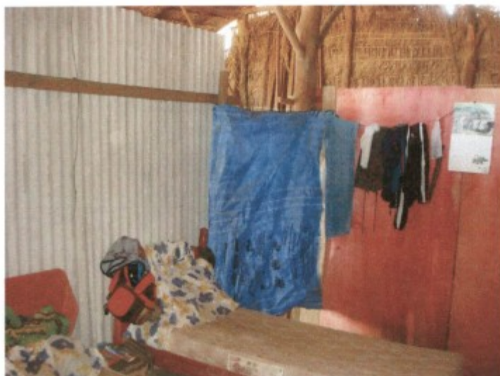
Foto 03-O quarto era improvisado com divisórias parciais internas de madeirite e telhas de fibra, com porta de saco plástico.
