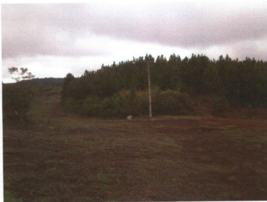
Posto com transformador no chão, indicando que não há energia elétrica no alojamento
