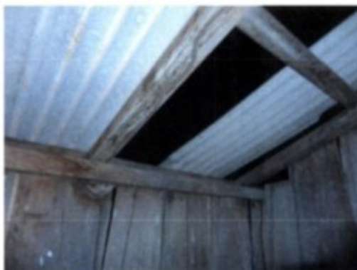
Telhado da fossa seca.
