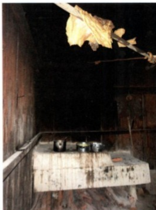
Cozinha destinada a uso dos empregados.
