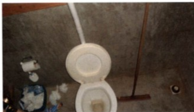
Sanitário da sede, disponível para a turma da varanda.
