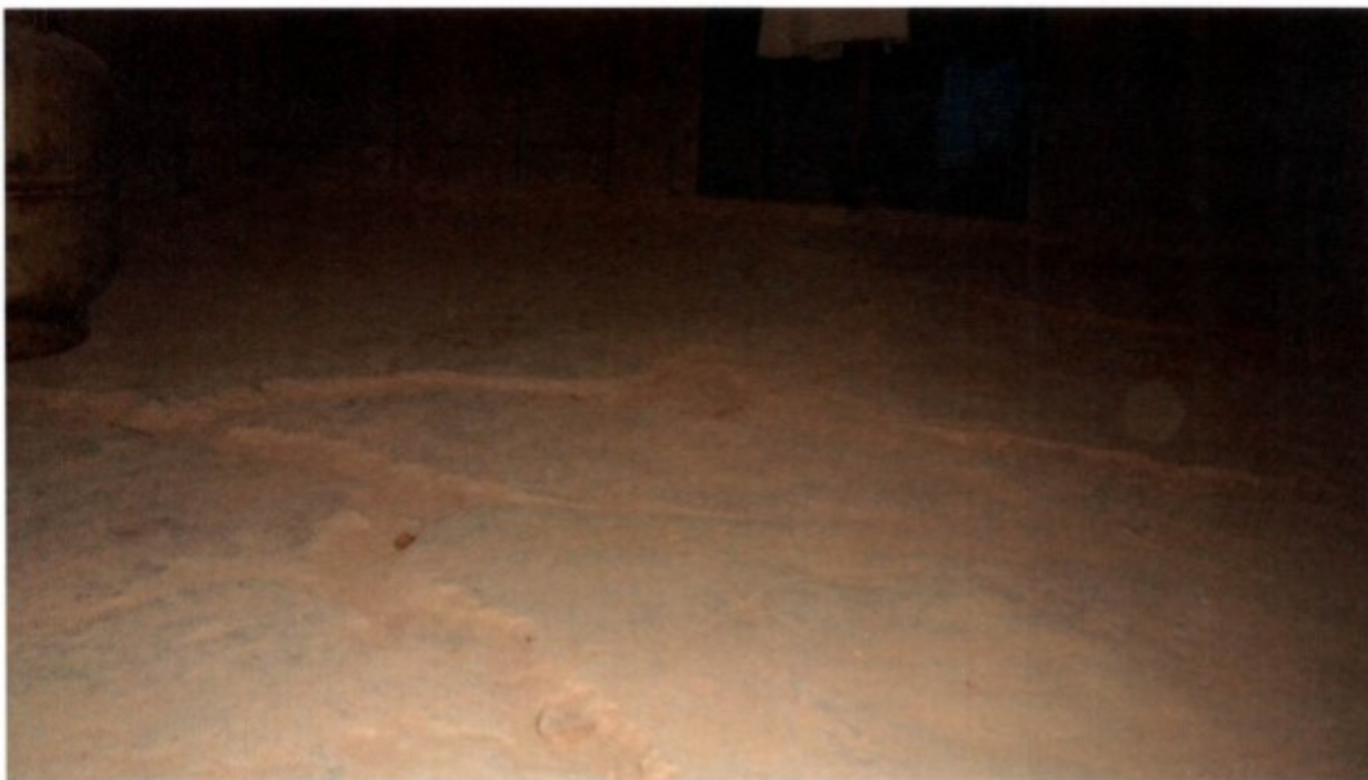
Piso no interior do barraco de madeira.
