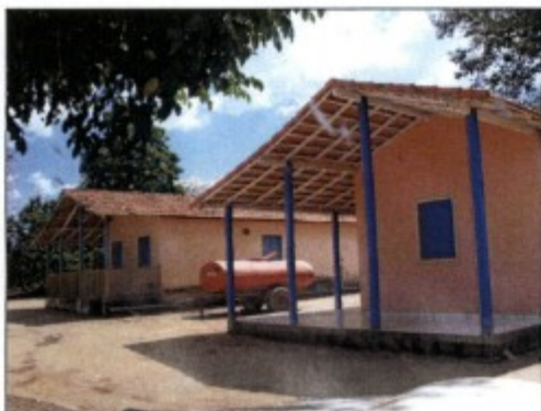
Alojamento dos trabalhadores fixos
