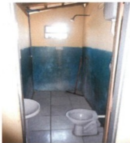
Fig. 10: Banheiro da sede da fazenda.
