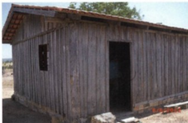
Fig. 11: Casa habitada pela cozinheira, pelo seu marido tratorista da fazenda e pelo trabalhador de apelido [redacted]
